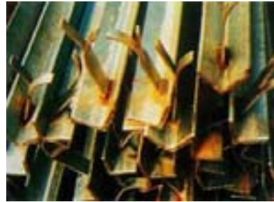
Abb. 18: Fehlstellen im Zinküberzug durch nicht entfernte Schweisschlacken
